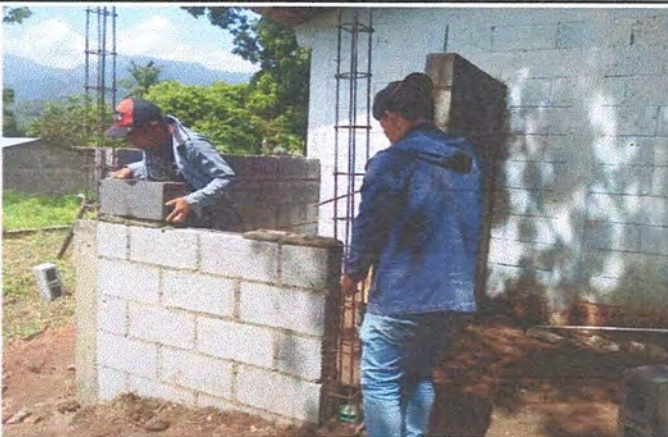
Foto 3: AVANCES DEL MEJORAMIENTO DEL BAÑO
